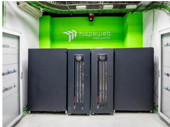
Instalación de UPS 1
