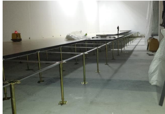
Fotografía hecha durante la instalación del suelo técnico
